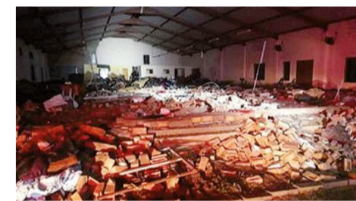
Ciò che resta della chiesa crollata a Dlangubo
